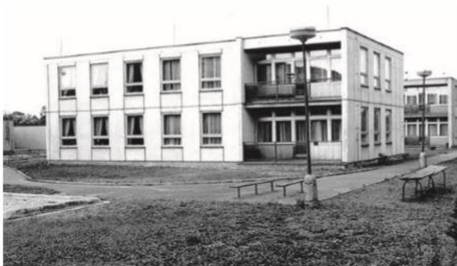
V roce 1983 byly v rámci akce-Z postaveny dva pavilony se čtyřmi třídami
